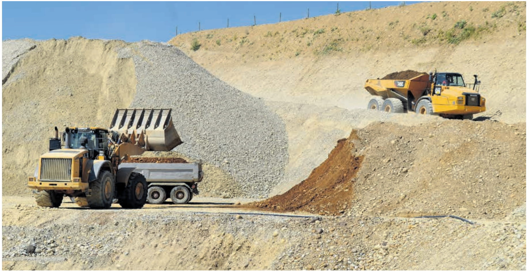
Der Kiesabbau in der Zeller Allmend ist für die regionale und überregionale Kiesversorgung von grosser Bedeutung. Fotos zvg
